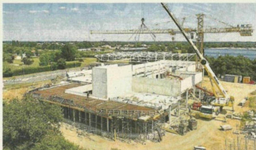
Vue aérienne du chantier situé près du centre-ville de Sainte-Pazanne.
