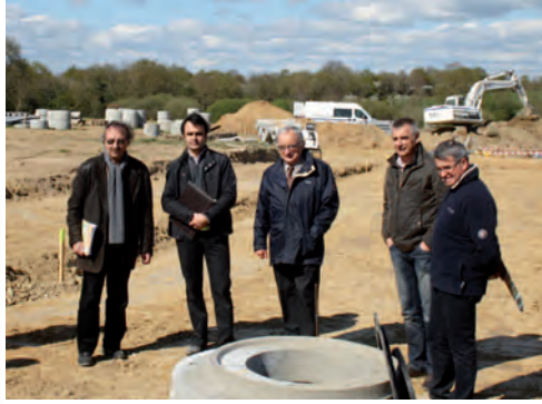
Visite de chantier du Parc d'activités du Pont Béranger 2
